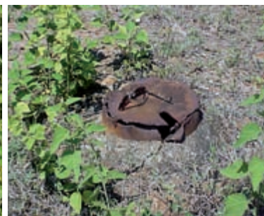
Poço abandonado e não tamponado, com laje e tampa quebradas. Fotos: Arquivo do IG/SMA
