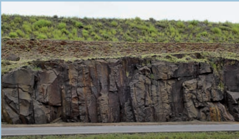
Limeira (SP) – Rodovia dos Bandeirantes – Diabásio em corte de estrada Fotos: Sibeze Ezaki
