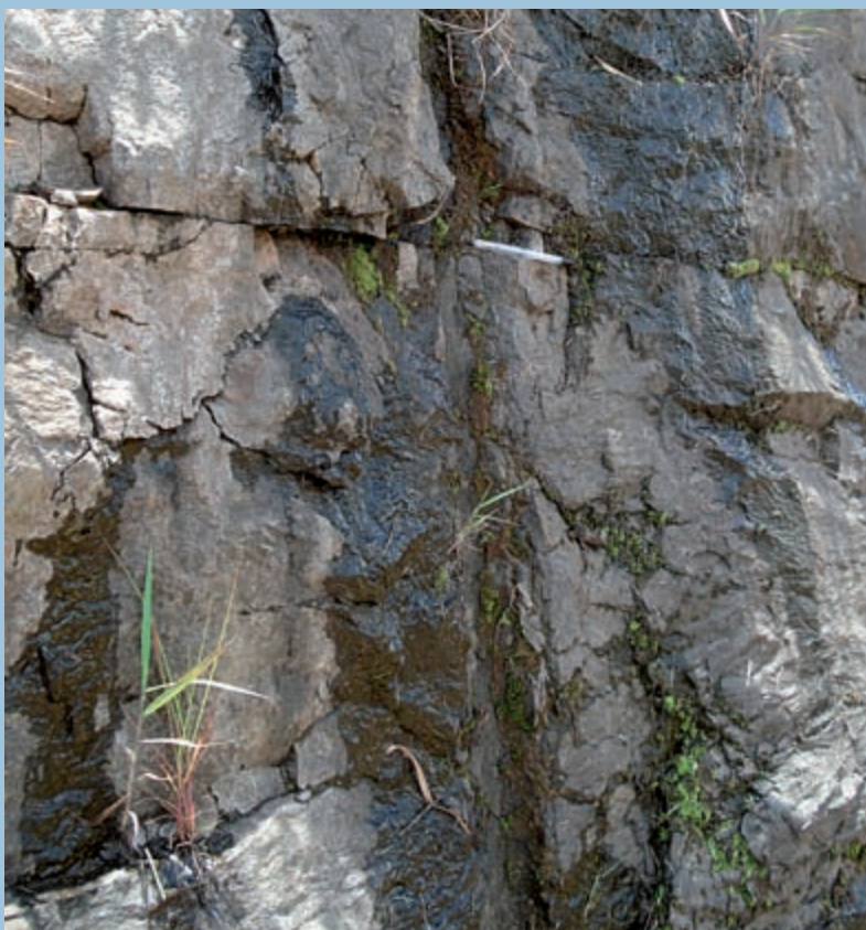
Limeira (SP) – Rodovia dos Bandeirantes – Detalhes das fraturas no diabásio. Fotos: Sibeze Ezaki
