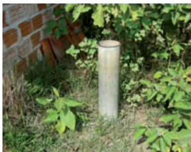
Poço com trinca na laje de proteção e tampa mal colocada.
